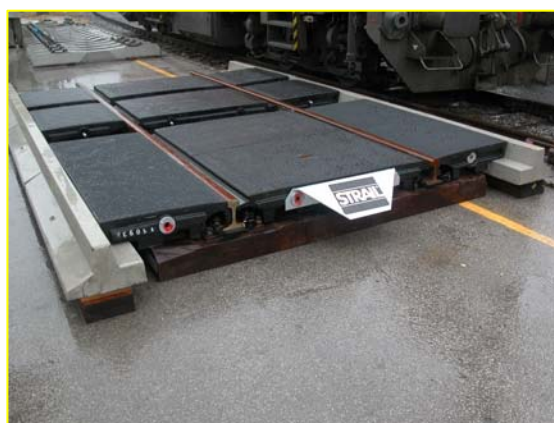
STRAIL rendszerű gumielemes útátjáró (II.B.)
